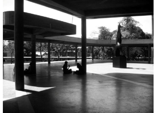
Visita a la Plaza Cubierta de la Ciudad Universitaria de Caracas, 1952-1953. Carlos Raúl Villanueva
